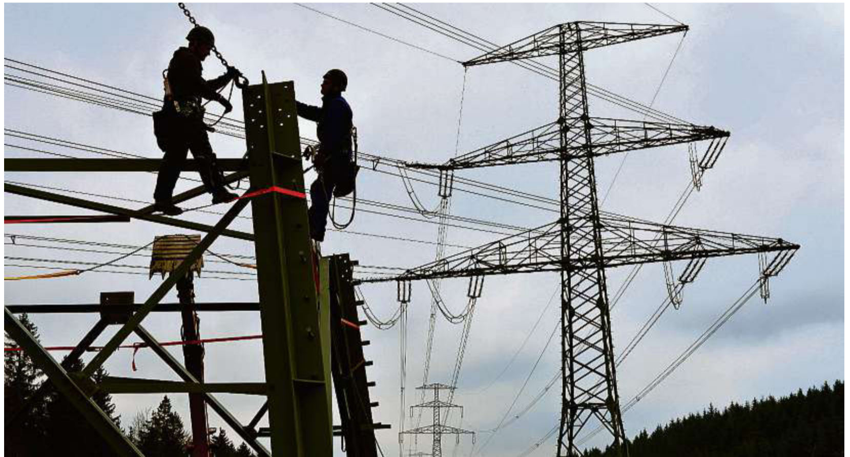
Der Bau neuer Stromleitungen stockt. Das bedroht laut Bundesnetzagentur die Sicherheit der Netze. Horst Seehofer sieht das anders.
