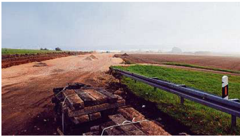
Die Erschließungsarbeiten für ds Gewerbegebiet sind bereits in vollem Gange.
