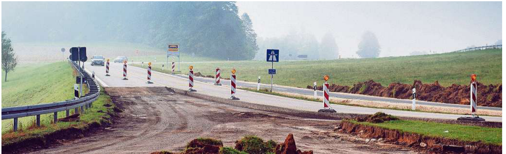
Direkt an der Ausfahrt Brunn der Autobahn A 3 wird schon bald ein Gewerbegebiet mit Tankstelle errichtet.
